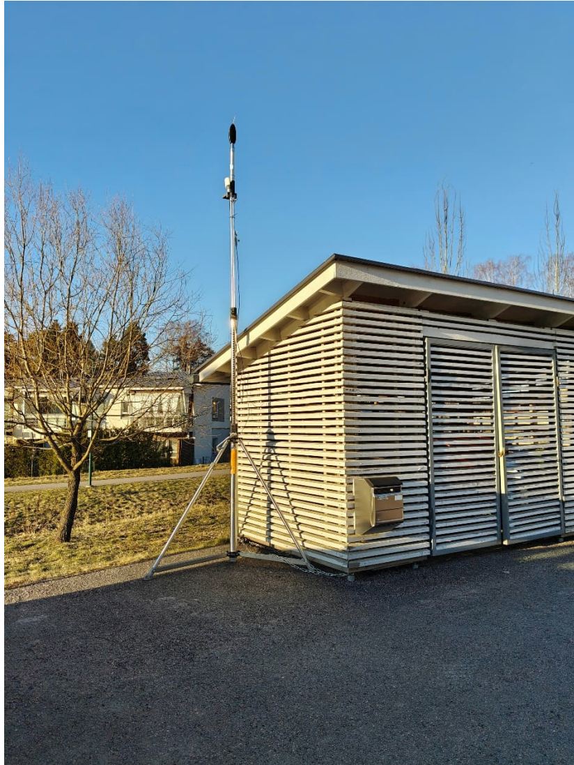
Kuva 2. Mittauslaitteisto kuvattuna etelästä
